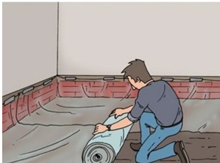
Afdekken vloer met PE-folie (bron www.zonnepanelenophetdak.nl )
