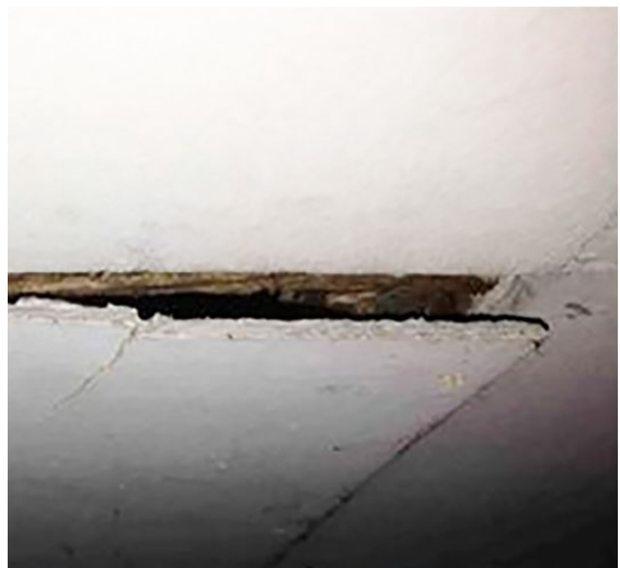
Losgebonden asbestplaat
