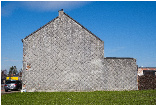
Grijze asbestcement gevelplaten
