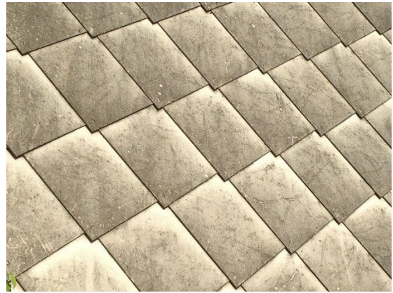
Grijze asbestcement gevelplaten
