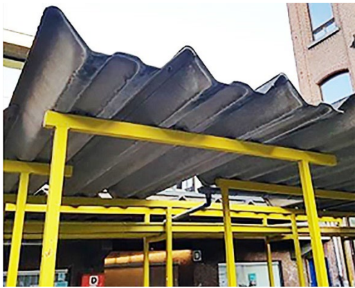
Grijze asbestcement golfplaten met grote golf
