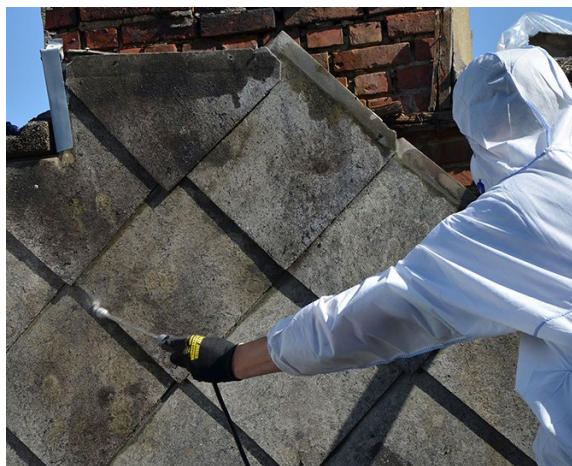
Aanbrengen fixeermiddel op gevelleien
