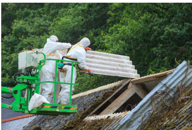
Veilige werken met asbest en hoogtes (bron: Dossier 150 Constructiv)
