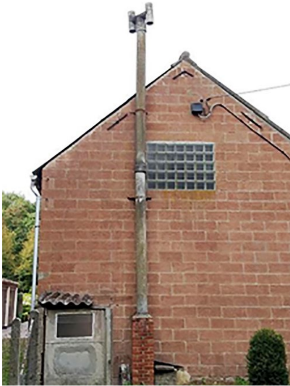
Grijze asbestcement schouwpijp en –kap
