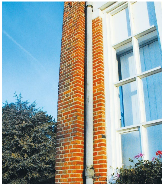
Grijze asbestcement regenwaterafvoer
