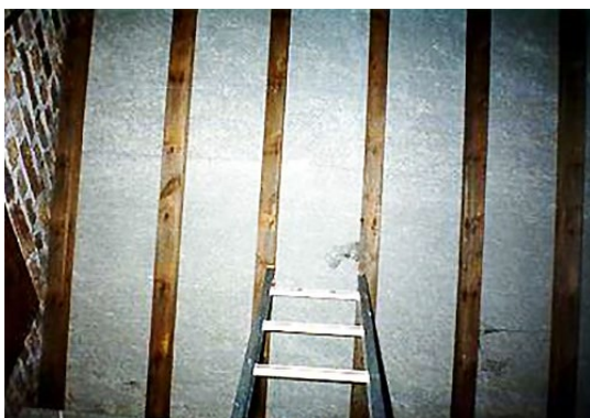
Grijze asbestcement onderdakplaten
