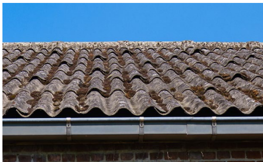
Grijze asbestcement golfplaten en dakleien
