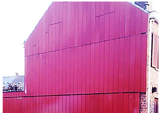
Rode asbestcement gevelplaten
