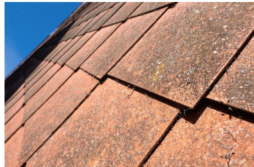
Grijze en rode asbestcement gevelleien
