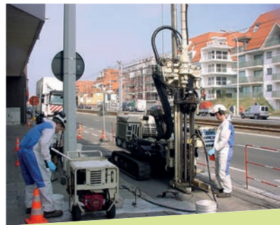
Injectie van producten om de biologische afbraak van de verontreiniging te stimuleren.
