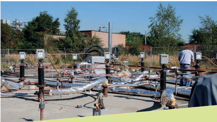
Oppompen van de verontreiniging na opwarming van de bodem
