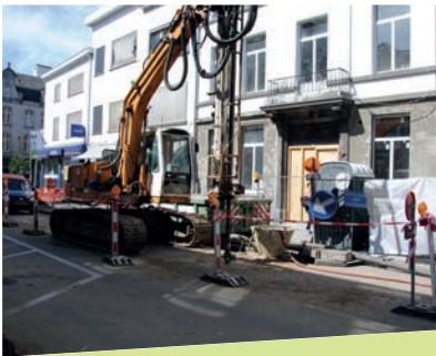
Plaatsen van filters voor het onttrekken van de verontreiniging.
