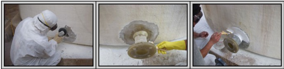
Figuur 54: Herstelling van een tankuitlaat ( http://www.armorshieldlining.com/fiberglass-tank-nozzle-repair.html )
