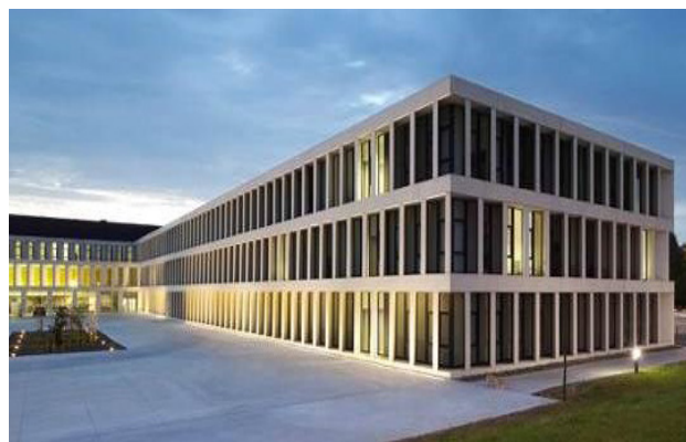
AZ Groeninge is een ziekenhuis dat in de toekomst uitgebreid en aangepast kan worden. De polyvalente draagconstructie maakt het bijvoorbeeld mogelijk een extra verdieping te bouwen op bepaalde vleugels en laat verschillende invullingen toe. © baumschlager eberle
