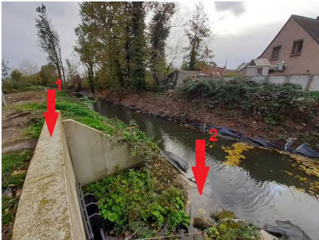
Foto overstort t.h.v. Lumco site: (1) top; (2) basis
