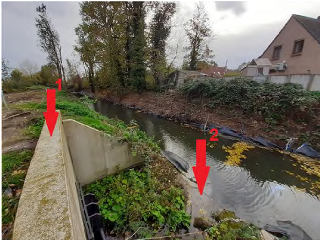
Foto overstort t.h.v. Lumco site: (1) top; (2) basis
