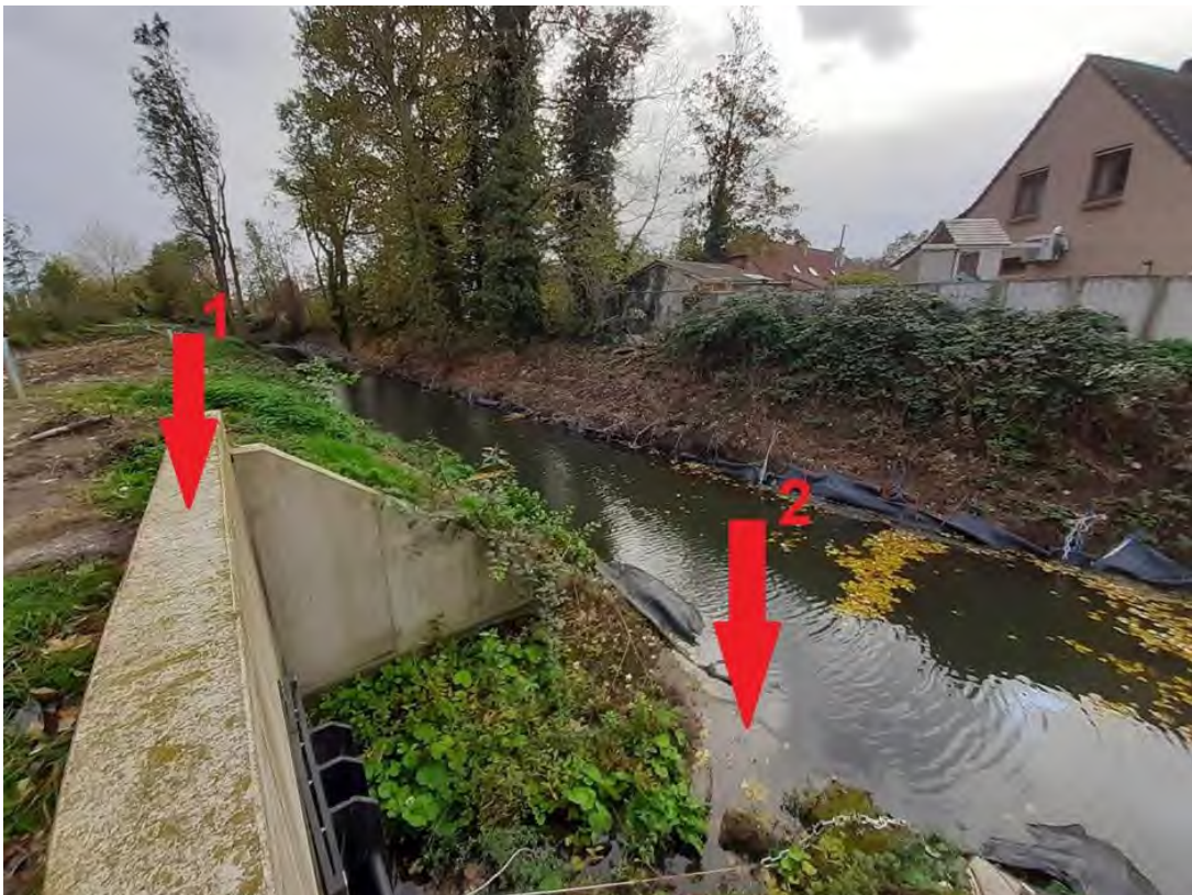
Foto overstort t.h.v. Lumco site: (1) top; (2) basis
