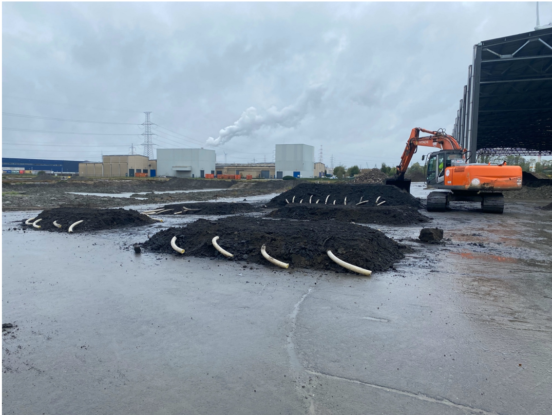
Figuur 30: Aanleg phytostacks
