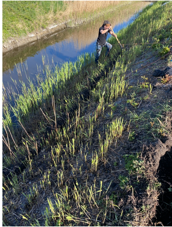
Figuur 27: Pilotzone 2 - V-vormige sleuf
