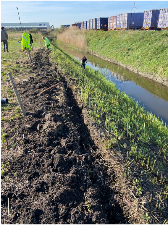
Figuur 26: Pilotzone 2 - sleuf drainagedarm
