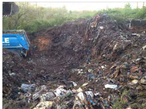
Figuur 3 : Overzicht ontgravingszone
