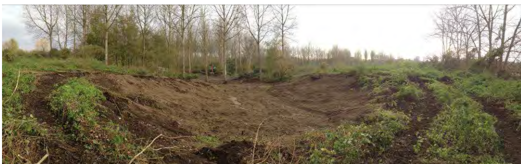
Figuur 4 : Situatie na ontgraving van stortmateriaal
