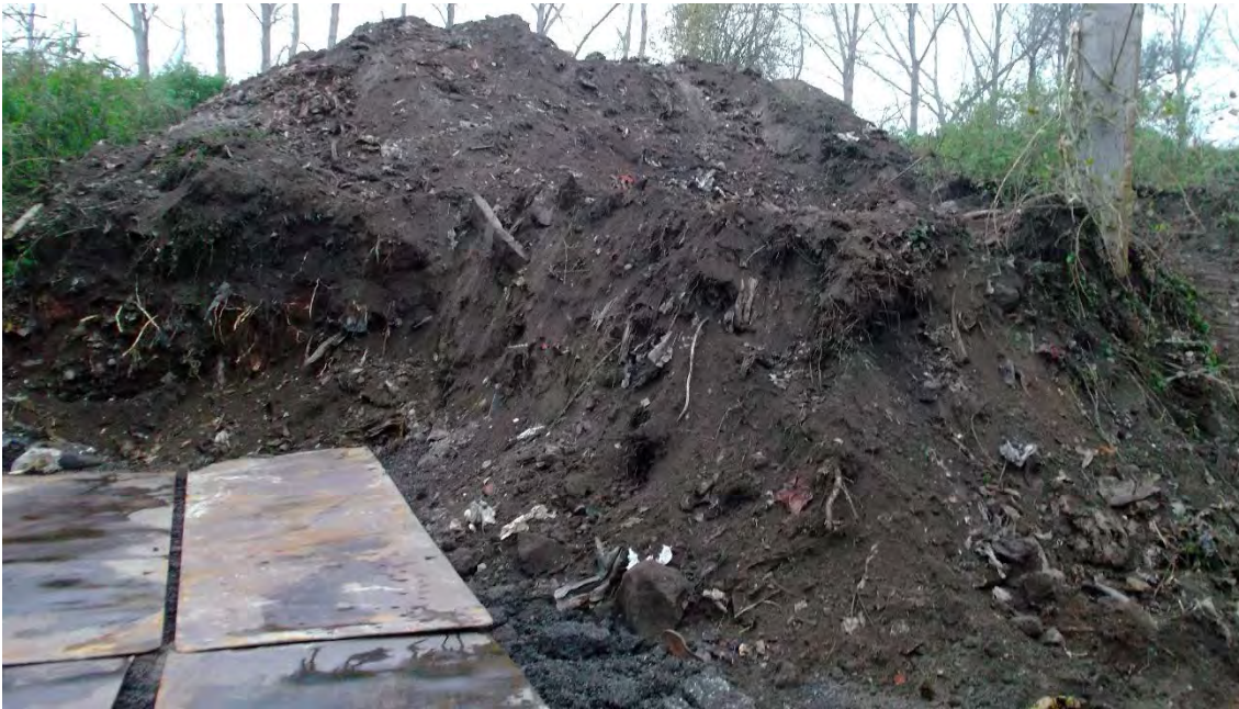
Figuur 9: Ontgraving stortplaats te Bornem
