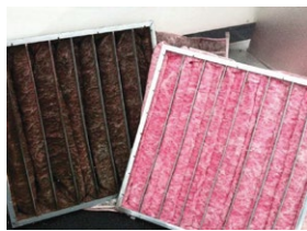
Glasvezel zakkenfilter: vervuild en nieuw.
