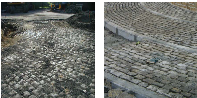
Figuur 30: Demontage en hergebruik van porfieren (“Materialen recupereren en recycleren”-Praktische Handleiding voor het ontwerpen van de openbare ruimten van duurzame wijken” – BIM)
