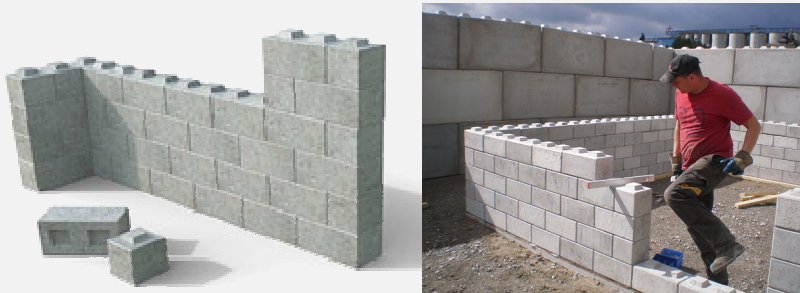
Figuur 40: Wand uit bouwblokken met omkeerbare verbindingen (Q-Brick systeem) 17
