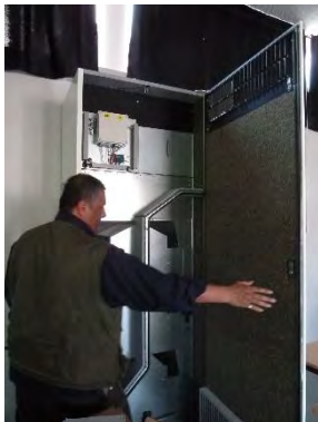
Ventilatie-unit Airmaster AMP900 filter F7 op luchttoevoer
