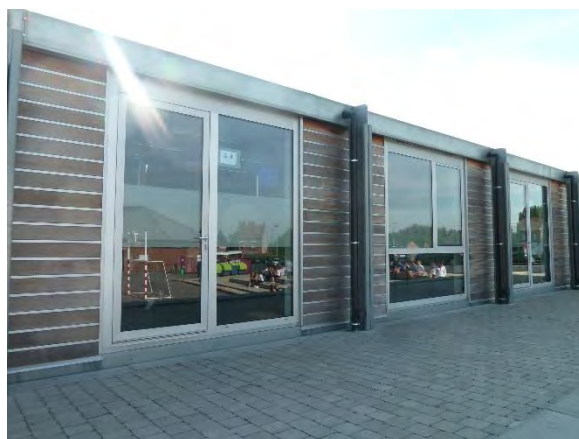
gevel klaslokaal G4
