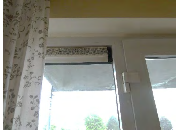
Ventilatieroosters ter hoogte van de ramen
