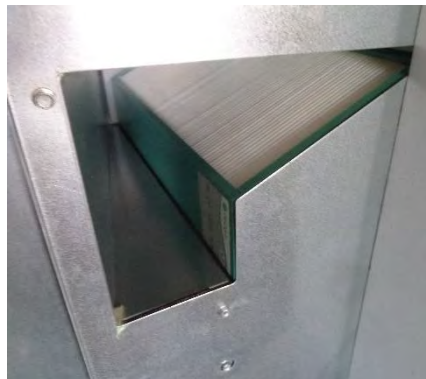
Ventilatie-unit Airmaster AMP900 filter F7 op luchttoevoer
