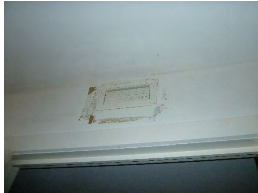
Sporen van plakband rond aanvoerroosters
