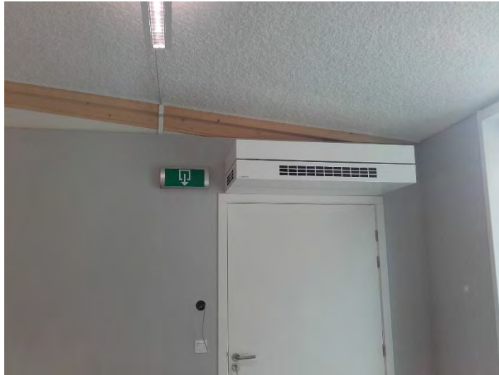
Ventilatie-unit directielokaal
