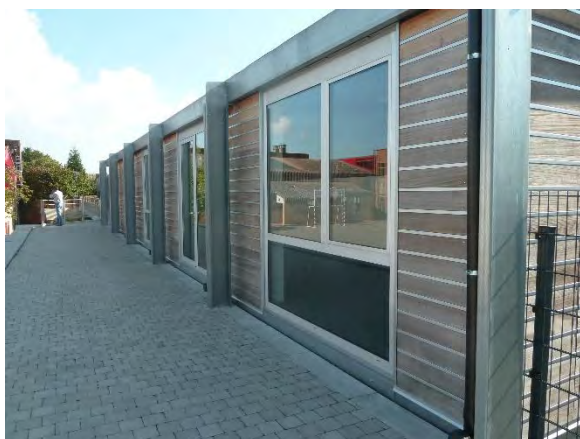
gevel klaslokaal G31
