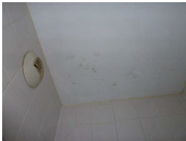
Badkamer: schimmelvorming ter hoogte van het plafond
