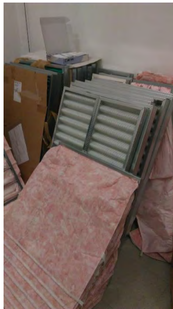
Dakverdieping: filters voor de verschillende luchtgroepen
