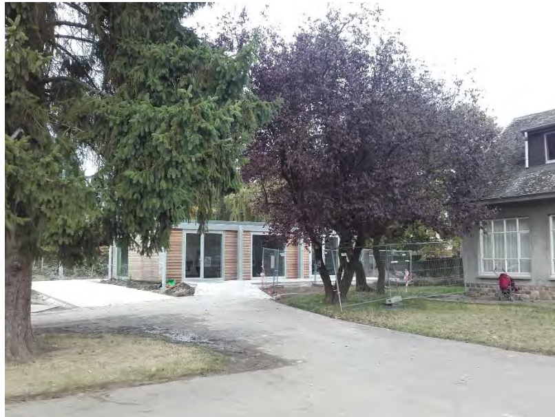
Aanleg van de speelplaatsen
