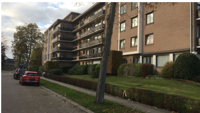
Meer 'dense' bebouwing ter hoogte van de Neerbroek
