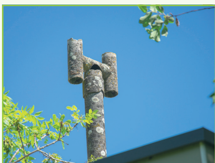
Asbestcementen schoorstenen en afdekkappen
