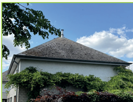
Asbestcementen dak
