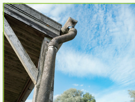
Asbestcementen afvoerbuizen en goten (regenpijp)
