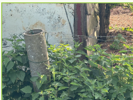
Asbestcementen omheiningsspelen
