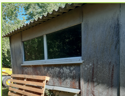
Asbestcementen gevelbekleding
