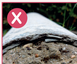
Verloren bekisting (bv. bij een steunpilaar)
