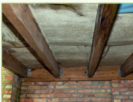
Asbestcementen (onder)dakplaten
