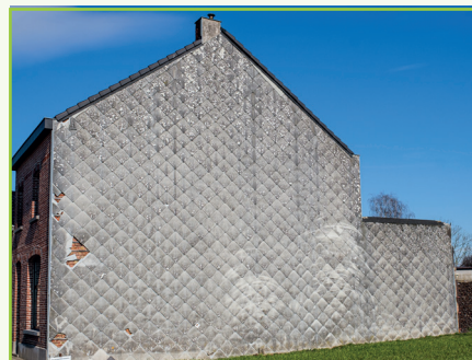
Asbestcementen gevelleien
