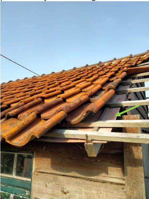
Figuur 7: Voorbeeld van niet-eenvoudig bereikbare onderdakplaten
