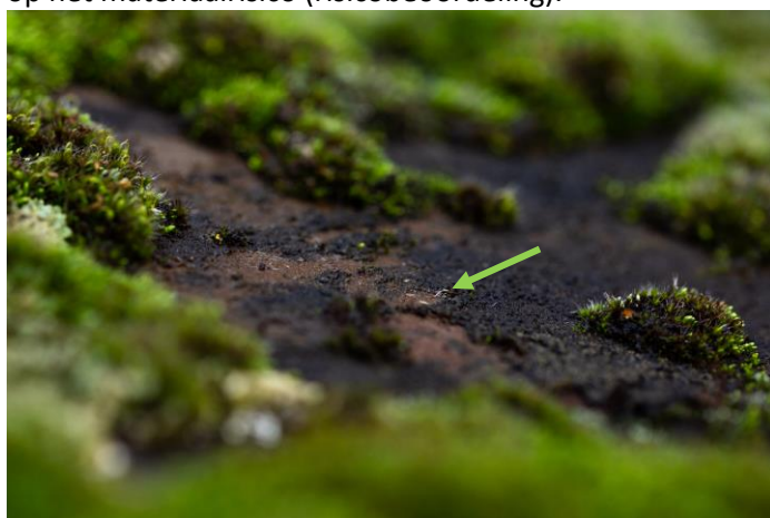
Figuur 45: Voorbeeld van vrijkomende chrysotielvezelbundels door degradatie (mos) van leien in vezelcement
