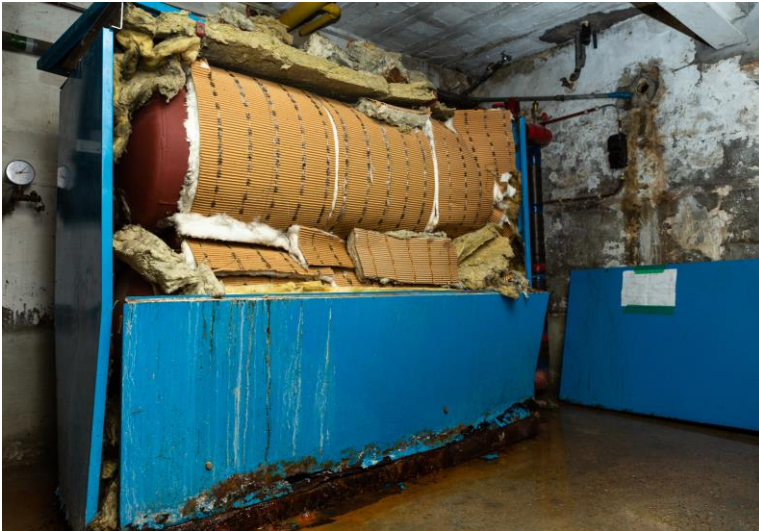
Figuur 24: Voorbeeld van bestaande opening aan een normaliter dicht gedemonteerde stookketel
