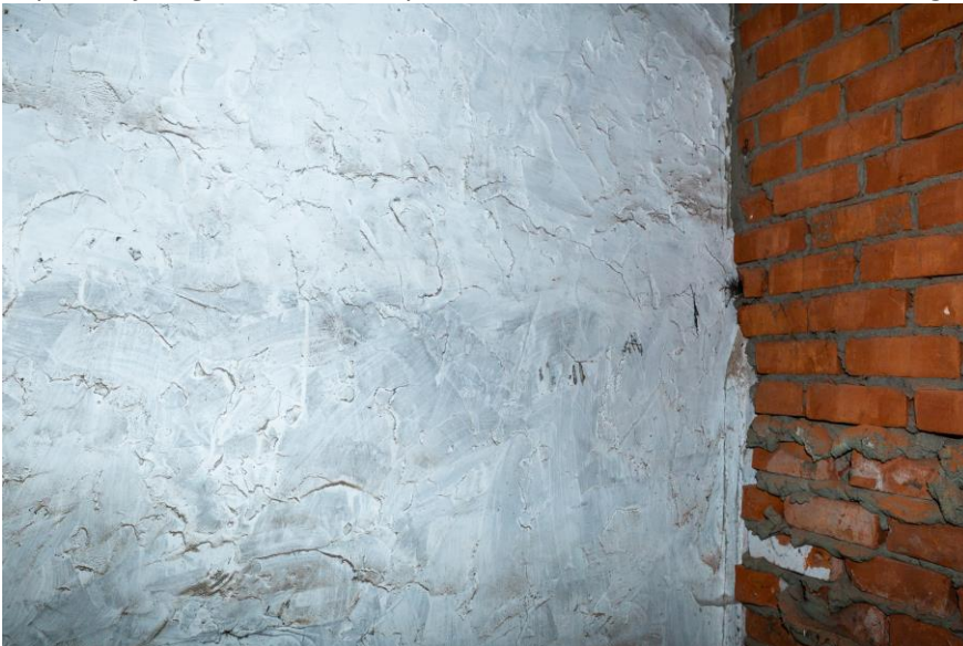
Figuur 52: Voorbeeld van pleisterwerk (overzichtsfoto)
