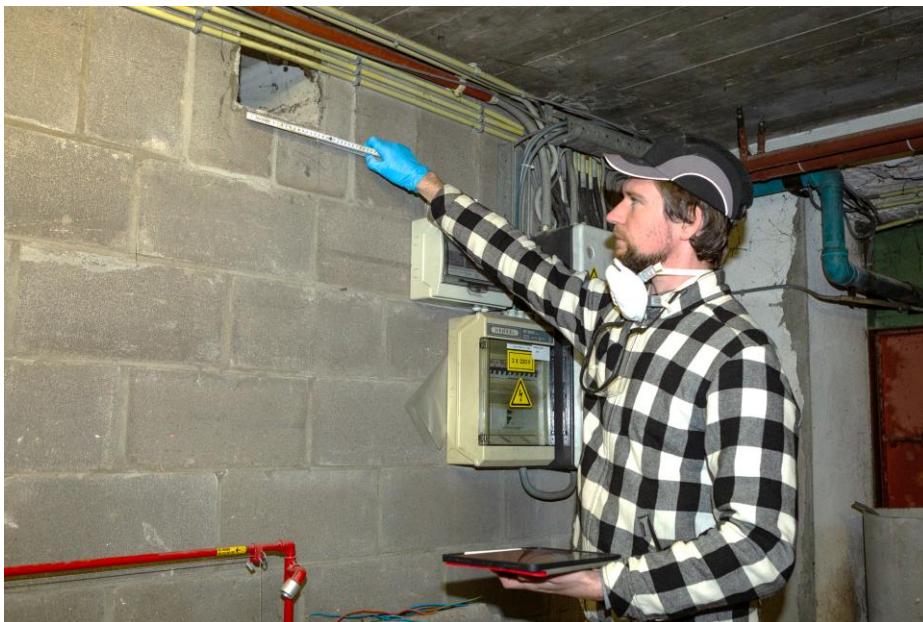
Figuur 66: Voorbeeld van gebruik van stootpet, veiligheidsbril, mondmasker, wegwerphandschoen en invoering van opmetingen in de databank
