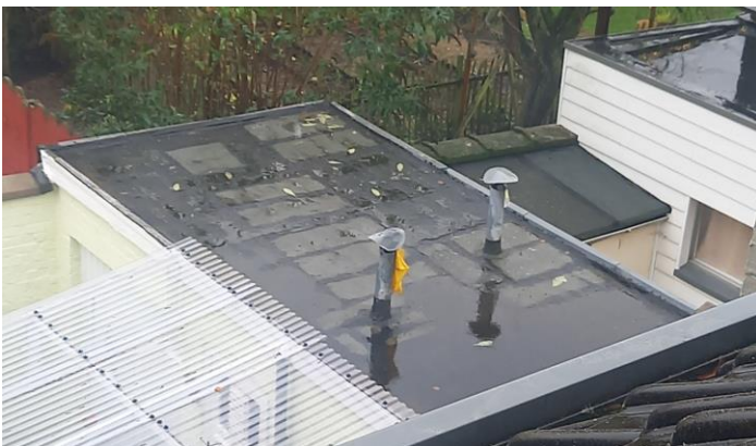
Figuur 37: Voorbeeld van een plat dak met roofing, gezien vanuit een dakvenster
