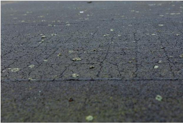
Figuur 55: Voorbeeld van roofing met bitumen afkitlaag
