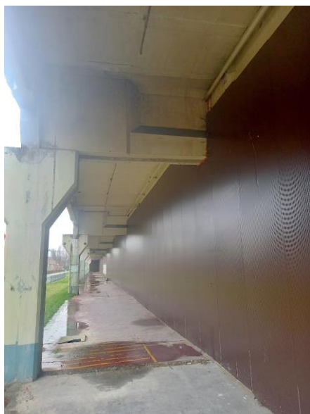
Figuur 8: Voorbeeld van niet fysiek bereikbaar plafond (> 3,50 m)
