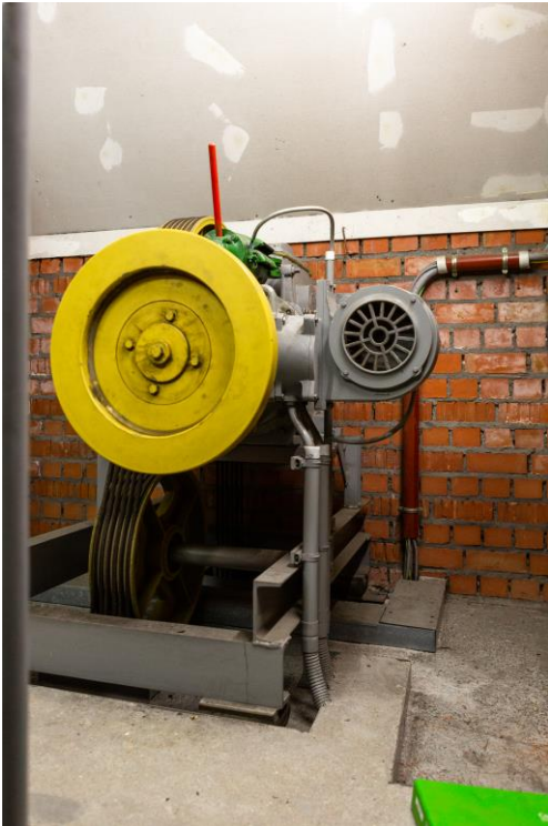
Figuur 56: Liftmachines bevatten soms het label 'asbestvrije remschoenen', ter plaatse aangebracht als sticker of in het onderhoudsdocument
