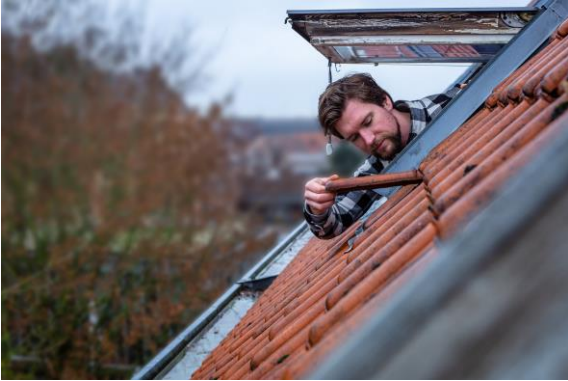
Figuur 30: Voorbeeld van opheffen van een dakpan
