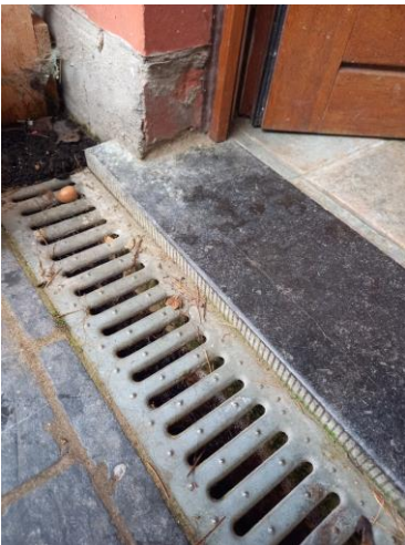
Figuur 35: Voorbeeld van waarneembare ruimte onder losliggend rooster
