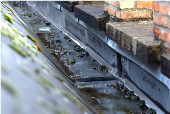
Figuur 77: Voorbeeld van sediment in een dakgoot, afkomstig van leien als dakbedekking
