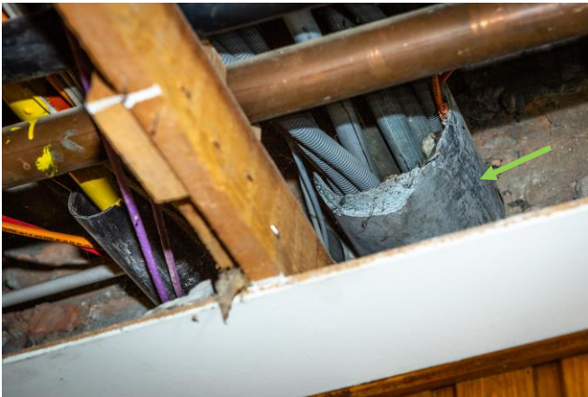
Figuur 10: Voorbeeld van een doorvoerbuis voor kabels
