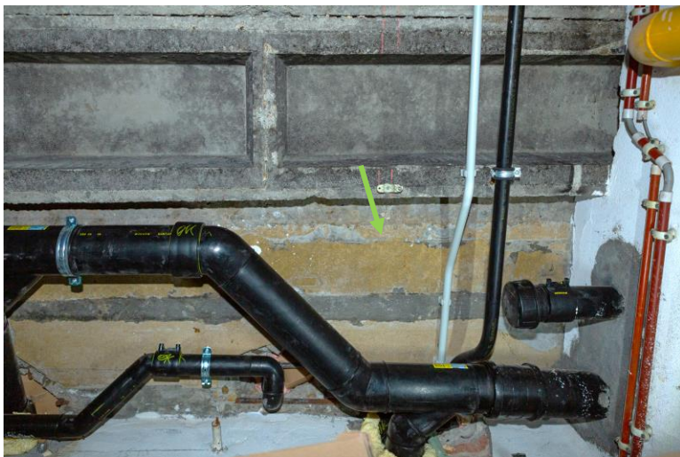
Figuur 6: Voorbeeld van platen type "Menuiserie" als verloren bekisting aan betonnen plafond
