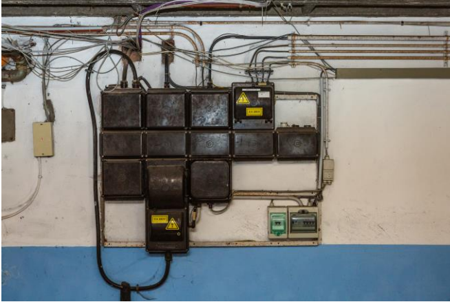
Figuur 11: Voorbeeld van bakelieten elektriciteitskasten
