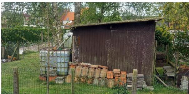
Figuur 78: Voorbeeld van golfplaten als dakbedekking en bijhorende regenwateropvang
