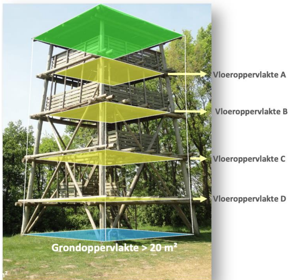
Figuur 19: grondoppervlakte van een toren
