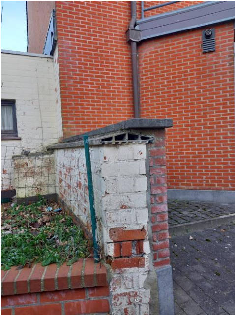
Figuur 73: Voorbeeld van een asbestverdachte (links) en niet-asbestverdachte (rechts) deksteen
