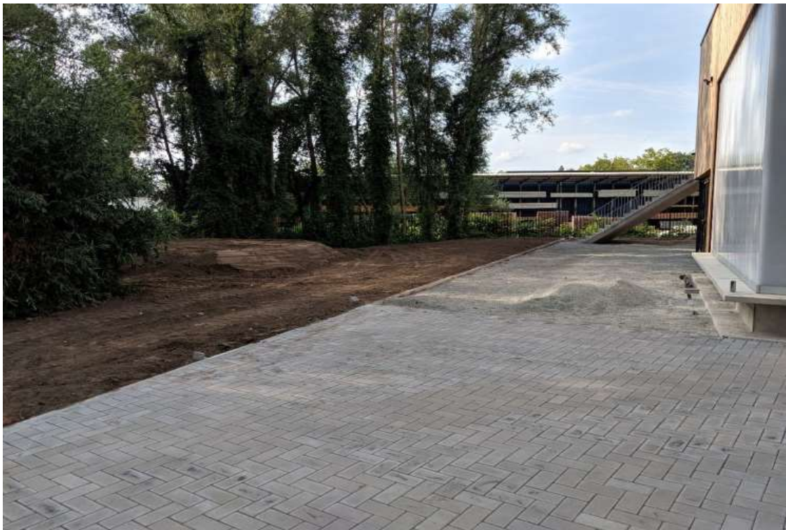
Zicht op westzijde onderzoeksterrein na nivelleren van het toekomstige grasveld
