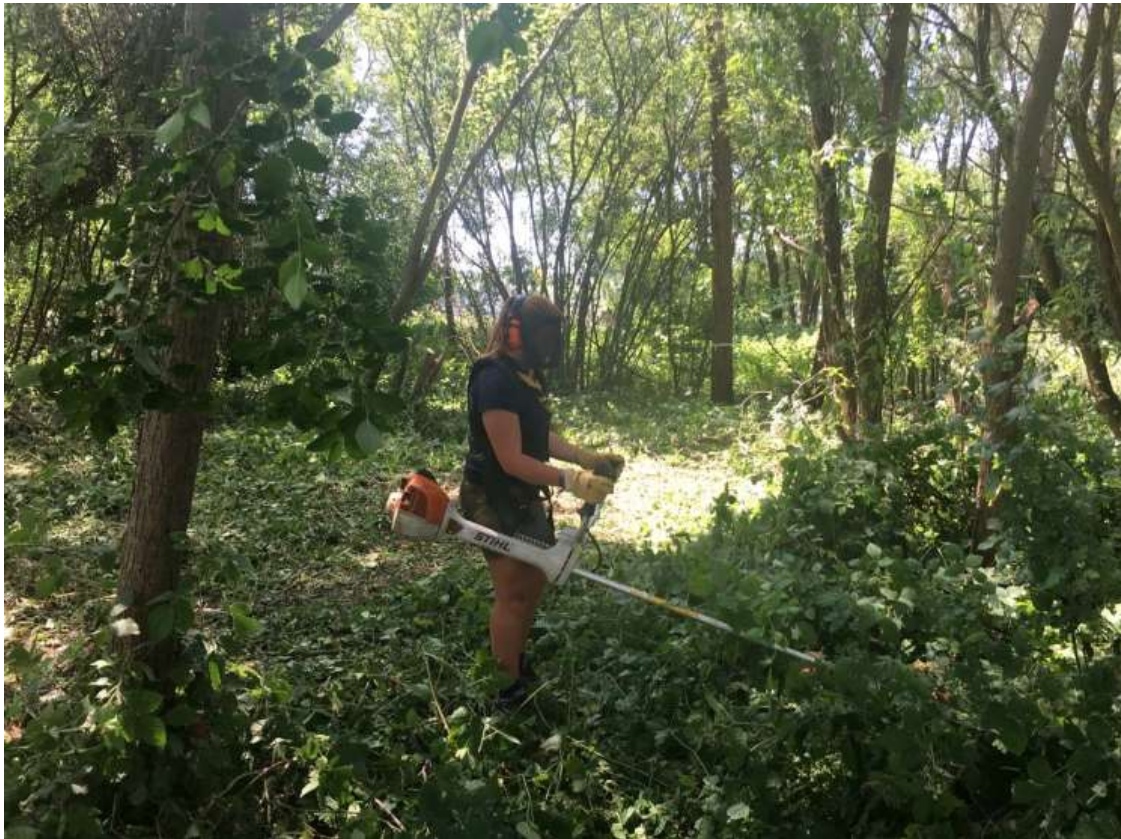
Verwijderen van de vegetatie in functie van de bouw van de lokalen
