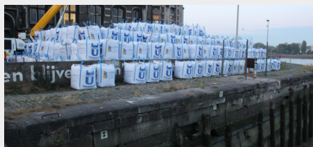
Belastingsproef kademuur Loodswezen Antwerpen (© SBE)
