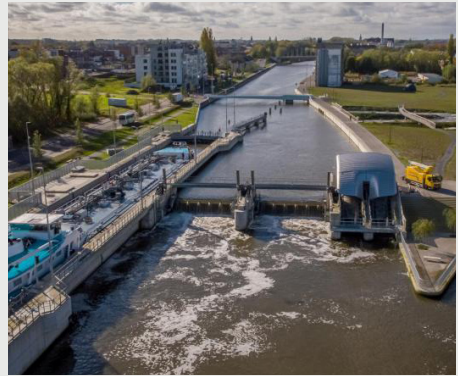
Sluizencomplex te Harelbeke met energieneutrale segmentstuw (© De Vlaamse Waterweg nv)
