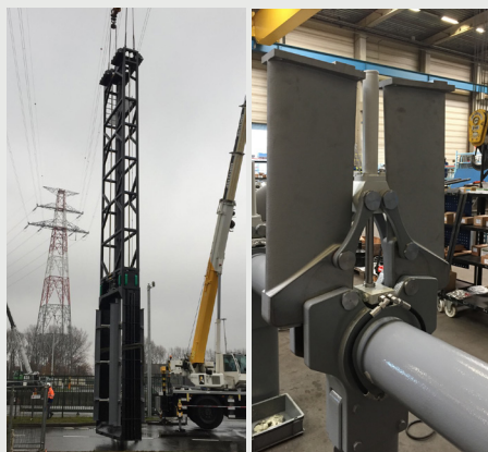
Installatie hydroturbine Kallosluis (© POAB)
