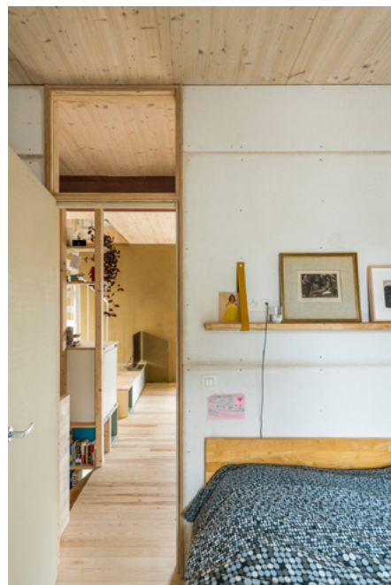
In de eengezinswoning 'Adriaan' in Mariakerke werden de schroeven van de gipsplaten zichtbaar gelaten waardoor ze in de toekomst gemakkelijk te demonteren zijn. © Luc Roymans
