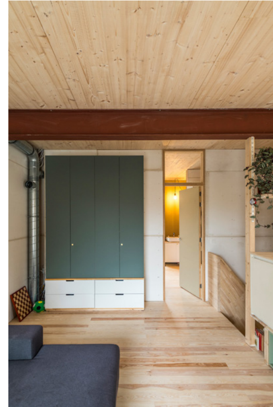
In deze eengezinswoning in Mariakerke werden de technieken zichtbaar gelaten. Een budget- en onderhoudsvriendelijke oplossing. © Luc Roymans
