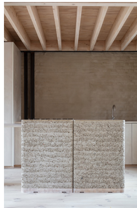
In het KAPER-project kreeg leem een prominente plaats: in de vorm van stampleem in een keukenmeubel en als leempleister voor de wandafwerking. Leem is een bijzonder materiaal: het behoort in principe tot de technische kringloop en kan dus perfect hoogwaardig gerecycleerd worden, maar het kan ook veilig teruggegeven worden aan de natuur. © Tim Van de Velde
