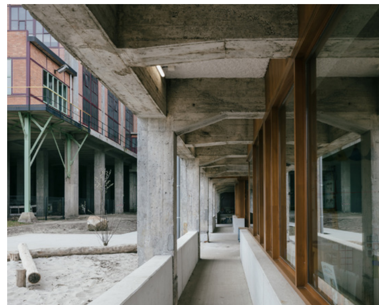
Bij de herbestemming van de badhallen van de oude mijnsite in Beringen naar de school KABO werd gebruikgemaakt van het box-in-boxprincipe om de originele gevel te behouden. © Stijn Bollaert
