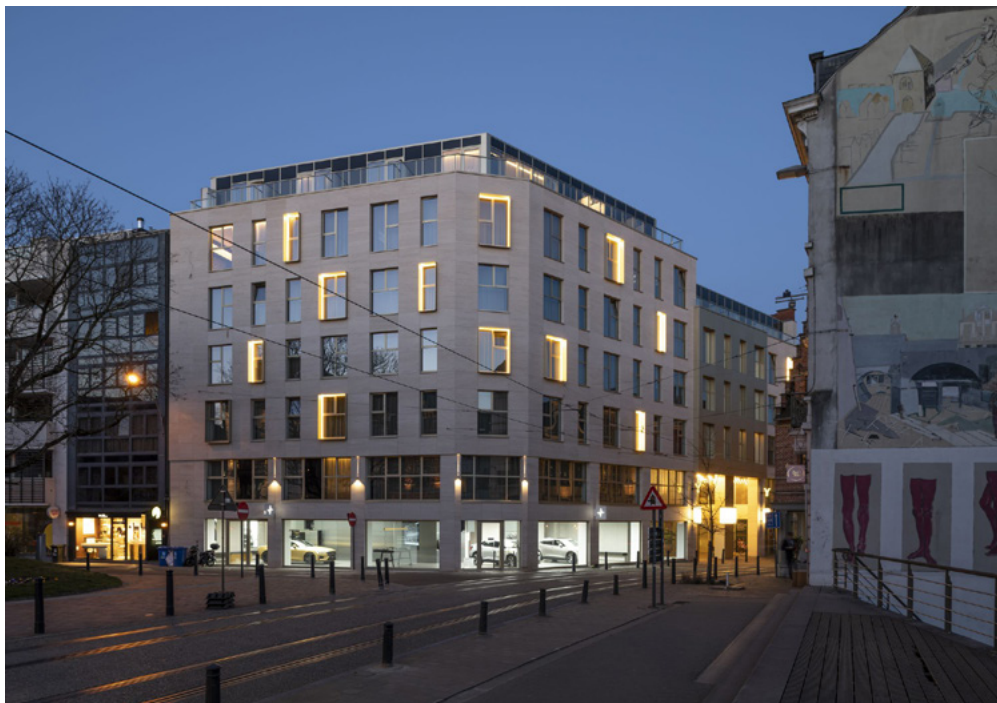
Tijdens de herbestemming bepaalde de kolomstructuur van een winkelcentrum de maat van de kamerverdeling en de ritmering van de gevelopeningen van het hotel Yalo. © Bontinck
