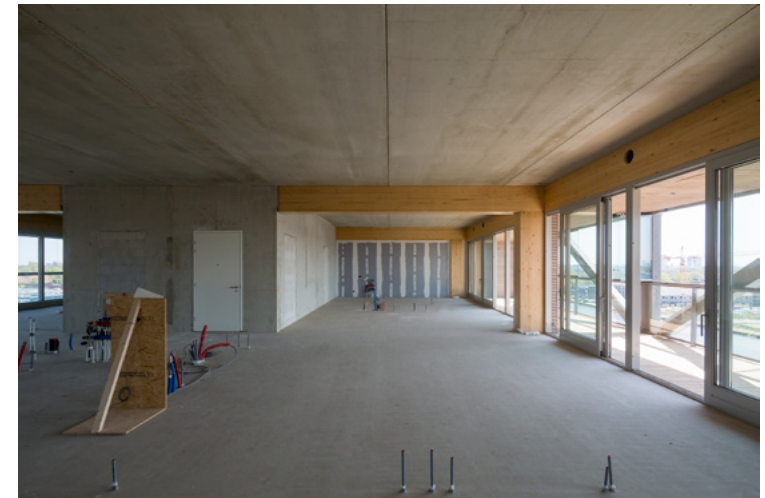
In het PATCH22-project werden de vloeren gedimensioneerd op 4 \text{ kN/m}^2 belasting in plaats van de gebruikelijke 2 \text{ kN/m}^2 . Zo kunnen de verdiepingen met een hoogte van 4m later andere functies huisvesten © Luuk Kramer
