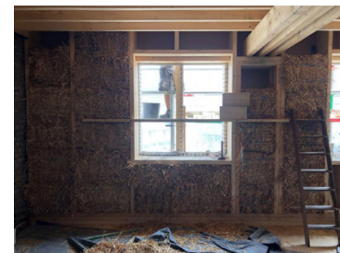
In het KAPER-project werd stro gebruikt om de optopping te isoleren. Gezien de minder complexe opbouw van de wand verschilt de dikte van de wand niet zoveel van die van een conventionele buitenwand. © Hé Architectuur
