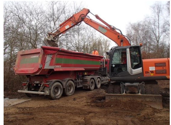
Stap 6: Opladen voor transport naar verwerker
