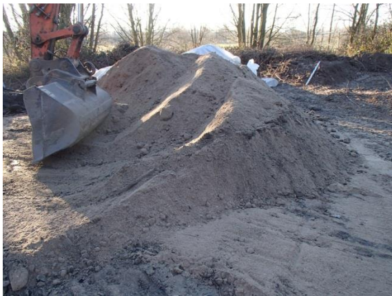
Stap 1: Mengen van zuurteer en houtstof
