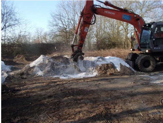
Stap 3: Inmengen van calcium oxide
