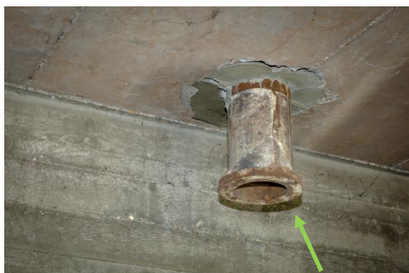
Figuur 65: Voorbeeld van beige resten van een flensdichting type "Klingerit"
