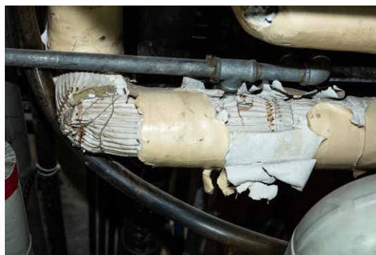
Figuur 54155: Voorbeeld van thermische leidingisolatie in gips
