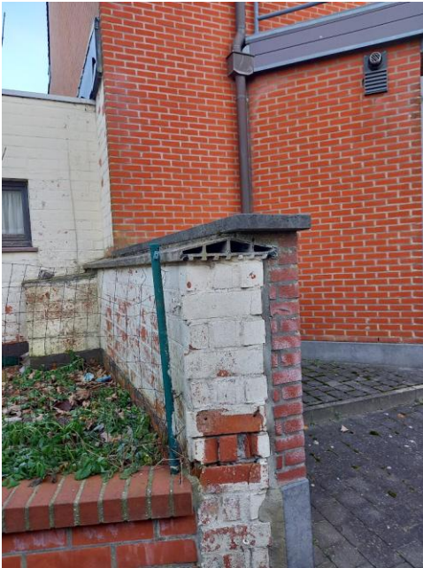
Figuur 70: Voorbeeld van een asbestverdachte (links) en niet-asbestverdachte (rechts) deksteen
