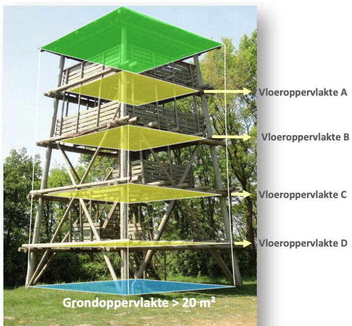
Figuur 27: Grondoppervlakte van een toren
