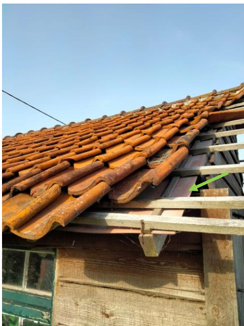
Figuur 59: Voorbeeld van niet-eenvoudig bereikbare onderdakplaten
