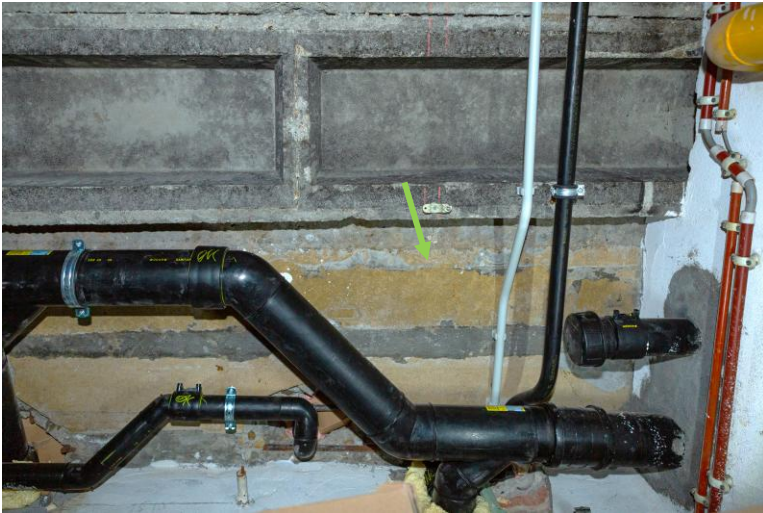
Figuur 58: Voorbeeld van platen type "Menuiserite" als verloren bekisting aan betonnen plafond
