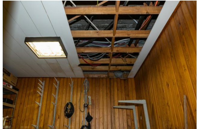
Figuur 49850: Voorbeeld van bestaande opening in verlaagd plafond met normaliter gemonteerde planchetten
