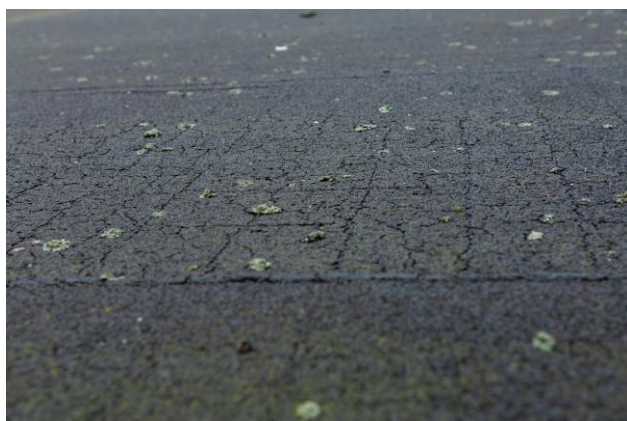
Figuur 4141: Voorbeeld van roofing met bitumen afkitlaag
