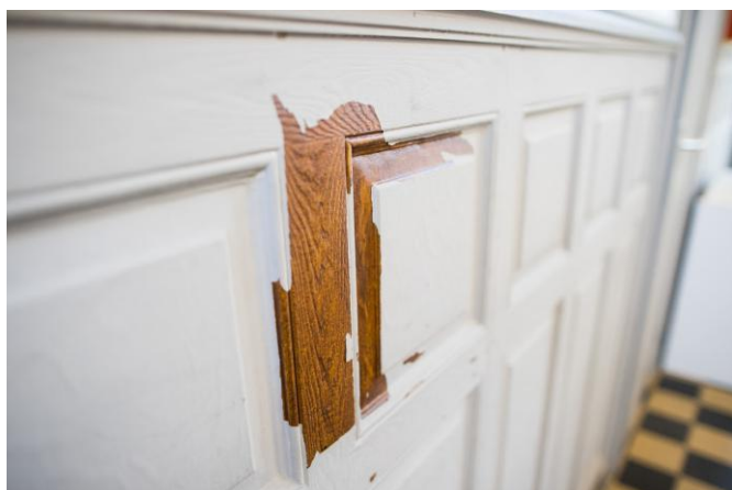
Figuur 69: Voorbeeld van lambrisering in vezelcement met uitzicht van hout
