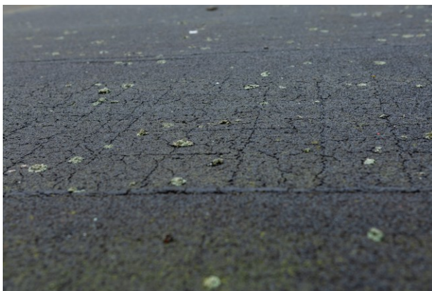
Figuur 40: Voorbeeld van roofing met bitumen afkitlaag
