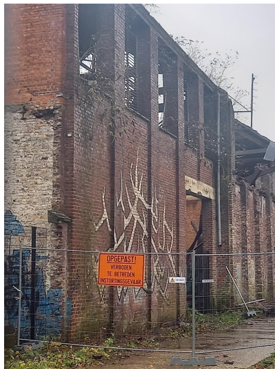
Figuur 33: Voorbeeld van veiligheidsbeperking (instortingsgevaar)
