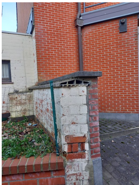
Figuur 67: Voorbeeld van een asbestverdachte (links) en niet-asbestverdachte (rechts) deksteen
