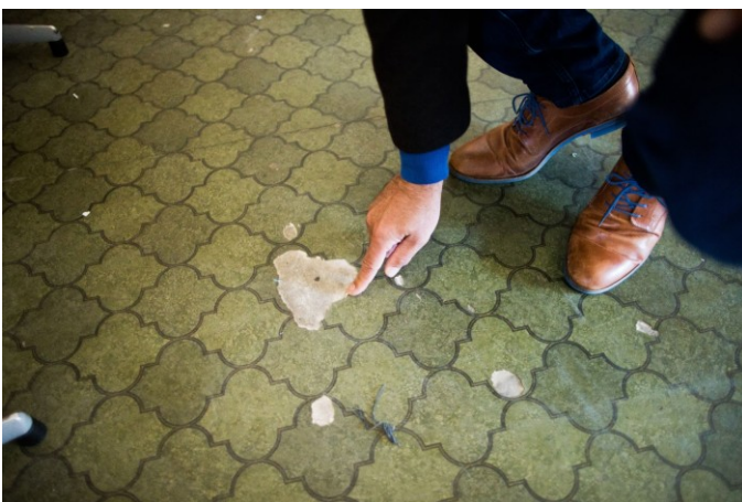
Figuur 48: Voorbeeld van vinylvloer met onderlaag in asbestkarton
