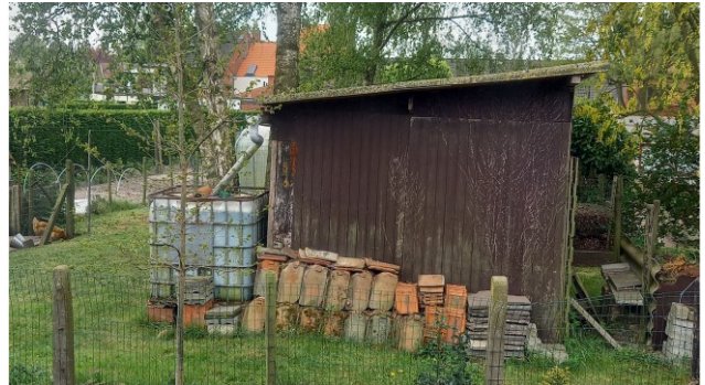
Figuur 44: Voorbeeld van golfplaten als dakbedekking en bijhorende regenwateropvang
