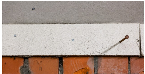
Figuur 39: voorbeeld van plaat type "Promatect"
