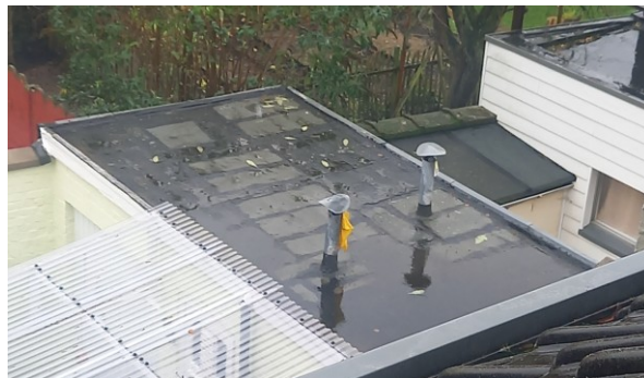
Figuur 7: Voorbeeld van een plat dak met een waarneembare en vast te stellen roofing, gezien vanuit een dakvenster
