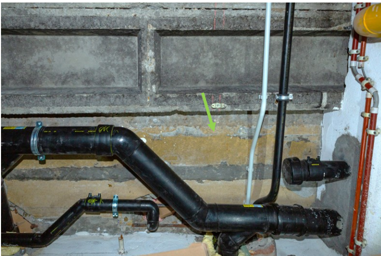
Figuur 52: Voorbeeld van platen type "Menuiserite" als verloren bekisting aan betonnen plafond
