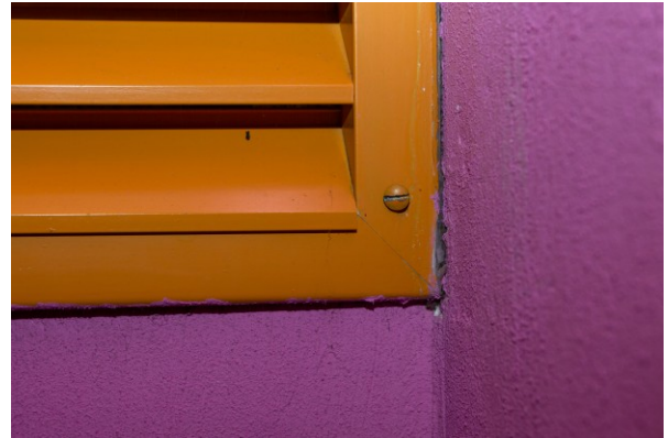
Figuur 6: Voorbeeld van niet-waarneembare ruimte achter dichtgeschroefd rooster die de ADI kan onderzoeken met een endoscoop.
