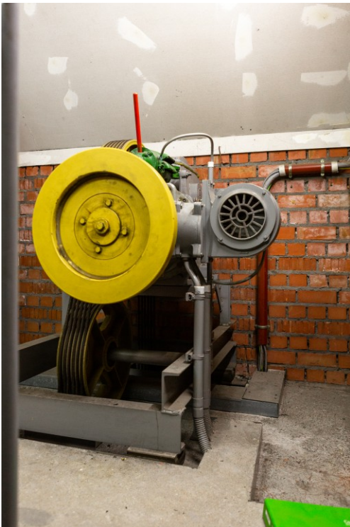
Figuur 36: Liftmachine: uit het onderhoudsdocument, dat als bewijsdocument geldt, staat dat de remschoenen vervangen werden in 2016
