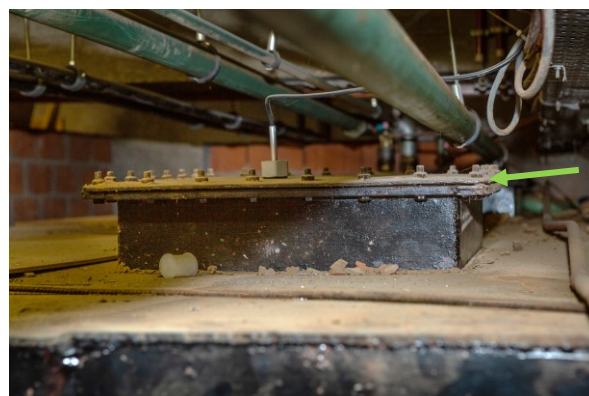
Figuur 60: Voorbeeld van een mangatdeksel van een stookolietank, met mogelijke dichting type "Klingerit"
