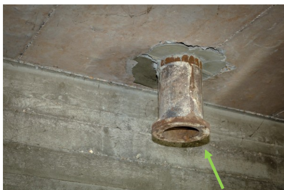
Figuur 59: Voorbeeld van beige resten van een flensdichting type "Klingerit"
