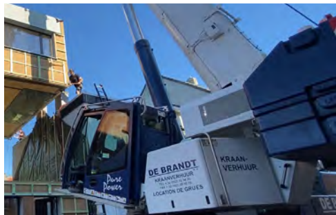
Twee Mobble-modules werden in de fabriek geassembleerd en afgewerkt op de site zelf © Inhout
