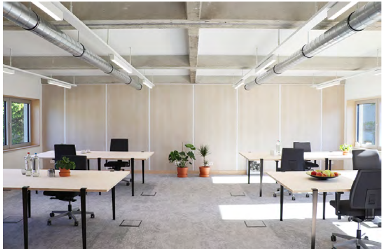
In het Circular Retrofit Lab werden de binnenwanden overgedimensioneerd en brandkleppen op de ventilatiekanalen voorzien waar later een brandwand komt. © Inneke Tavernier
