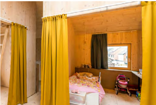
In de eengezinswoning 'Adriaan' in Mariakerke werd de optopping in CLT uitgevoerd. In amper twee weken was de verdieping klaar en de woning weer waterdicht. ©Luc Roymans
