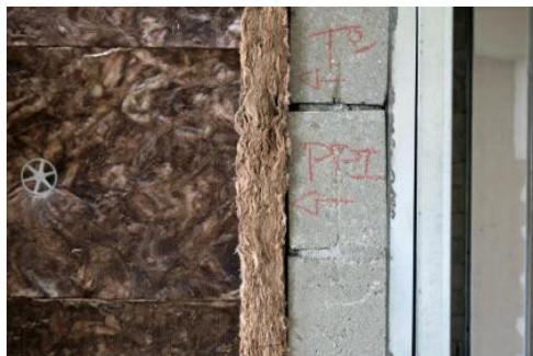
In het Ambassade-project werd tweedehands isolatiemateriaal gebruikt © Jonathan Ortegat
