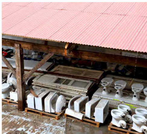
In het Ambassade-project werd een tijdelijke beschutte plaats ingericht om de materialen die op de situ hergebruikt worden te stockeren. © Stephane Lagasse
