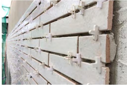
In het Dethy-project werden afgekeurde loten tegels gebruikt als gevelafwerking © Lionel Bousquet
