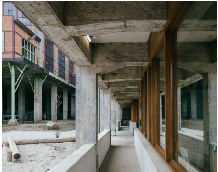
Bij de herbestemming van de badhallen van de oude mijnsite in Beringen naar de school KABO werd gebruikgemaakt van het box-in-boxprincipe om de originele gevel te behouden. © Stijn Bollaert
