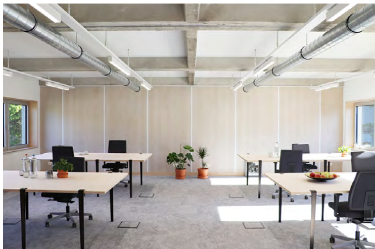
In het Circular Retrofit Lab werden de technieken deels in opbouw uitgevoerd en deels onder een computervloer. © Inneke Tavernier
