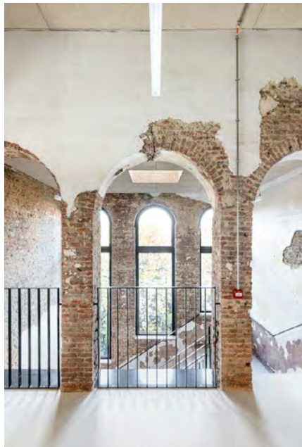
In het GO! Talentschoolgebouw in Dendermonde werd tijdens de renovatie de binnenafwerking beperkt aangepakt, waardoor de nieuwe ingrepen zeer zichtbaar zijn ten opzichte van het bestaand gebouw. © Lucid
