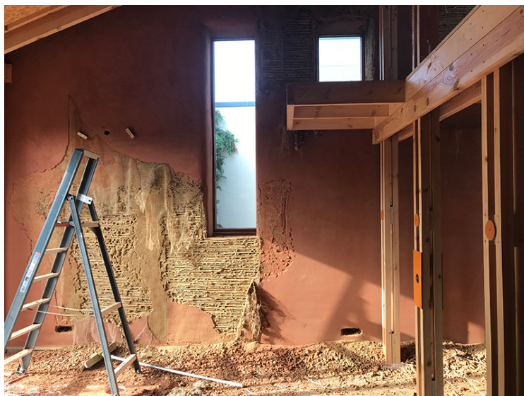
In het BRIC-project werd de leempleister er afgeklopt en opnieuw ingezet door het toevoegen van water - Bron: bamb2020.eu
