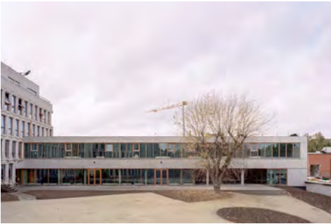
Na de herbestemming van het kantoorgebouw werd de school 'Karreveld' horizontaal uitgebreid. ©Séverin Malaud
